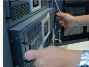
Para crecimiento o redundancia el diseño práctico y elegante de la serie ATP MODULAR permite un fácil reemplazo de módulos de potencia durante la operación en línea sin interrupción de energía en las cargas.
